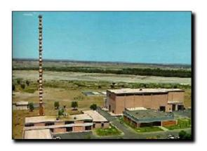
L'impianto ITREC (Impianto di Trattamento e Rifabbricazione Elementi di Combustibile), realizzato nel periodo 1965-1975, aveva come obiettivo la dimostrazione, su scala pilota, della fattibilità della chiusura del ciclo uranio-torio con il riprocessamento del combustibile esaurito e la rifabbricazione remotizzata del nuovo combustibile, utilizzando l'uranio (uranio-235 + uranio-233) e il torio recuperati.
