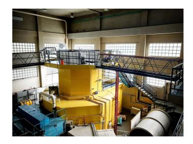
Nel Laboratorio Energia Nucleare Applicata (L.E.N.A.) dell'Università di Pavia è installato e funziona il reattore nucleare di ricerca TRIGA Mark II della potenza nominale di 250 kW.
