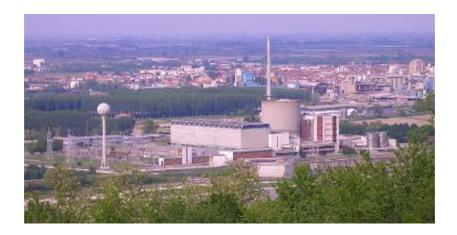
La centrale elettronucleare "Enrico Fermi" di Trino (VC), dotata di un reattore nucleare ad acqua pressurizzata Westinghouse del tipo PWR da 870 MWt (272 MWe), entrò in esercizio commerciale il 1/1/1965 e fu fermata il 21/3/1987, dopo aver prodotto complessivamente circa 25 miliardi di kWh. Con delibera CIPE del 26/7/1990 fu disposta la chiusura definitiva della centrale.
