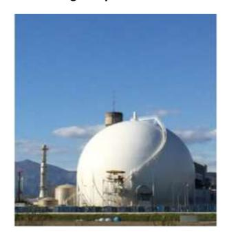
La centrale nucleare del Garigliano, sita in Sessa Aurunca (CE) e dotata di un reattore nucleare ad acqua bollente General Electric del tipo BWR da 506 MWt (150 MWe), entrò in esercizio commerciale nel giugno 1964, con una produzione elettrica complessiva, fino all'arresto definitivo, di circa 12 miliardi di kWh.
